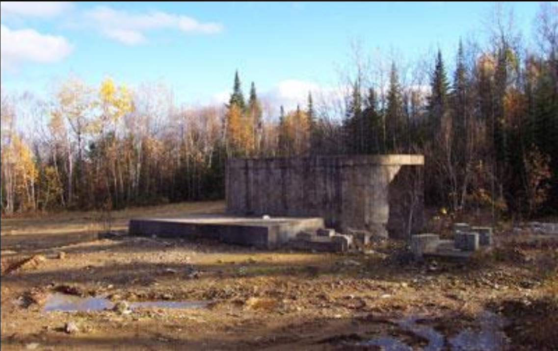
Entrée du puits Anacon
